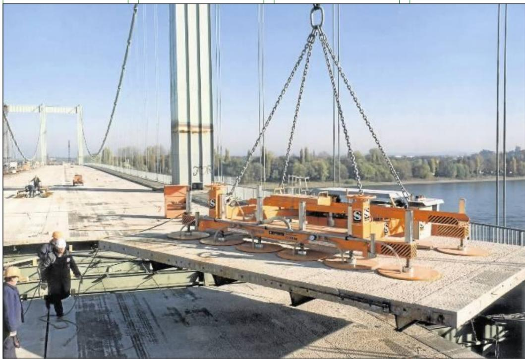
Scheinbar mühelos wuchten die Hebekonstruktionen mächtige Betonplatten an ihren Bestimmungsort. Foto Vacu-Lift
