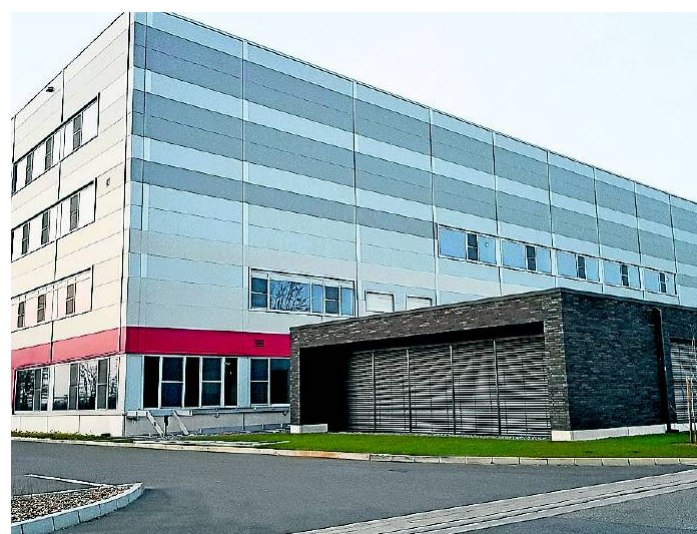
Die Nussrösterei Tadim ist ebenfalls ein Projekt der Austrup-Ingenieure.
