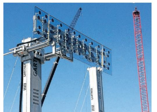
Die Glasfassade der neuen Apple-Zentrale in Kalifornien wurde mit Hilfe von Vacu-Liftern montiert. Hier erkennt man die Vakuum-Teller besonders gut. Foto: prf
